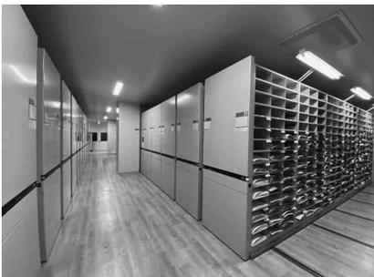
別館収蔵庫の1階、各レーンは電動で開閉できる。2階にも同じ設備があり、標本棚の数は15段×18列×108レーン(本館は42レーン)で計2万9160(本館は1万1340)を有する。
